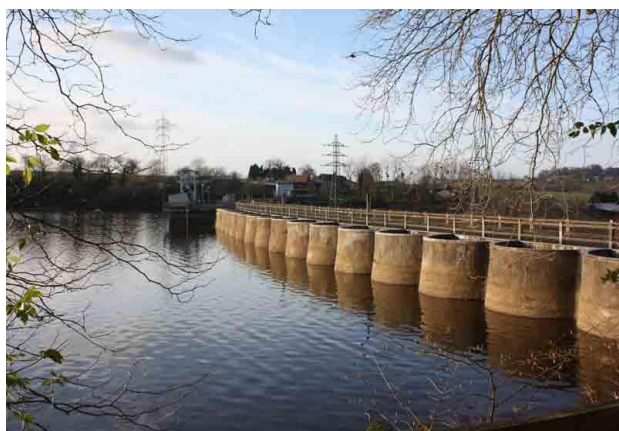
Barrage de VEZIN - 36 m
