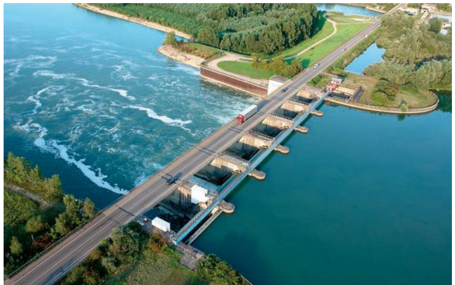
Une centrale au fil de l'eau, dans le Rhin (Iffezheim).
