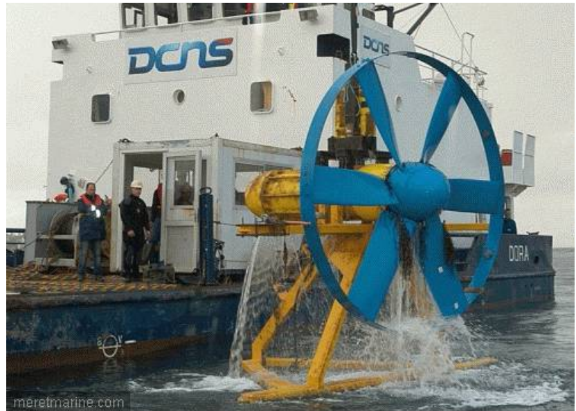
Pose d'un démonstrateur d'hydrolienne devant BENODET crédit : DCNS
